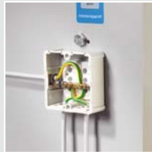
Terminal box for equipotential bonding cables.
